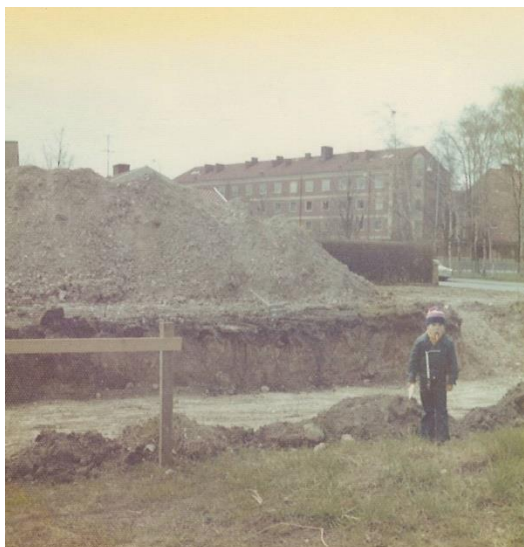
Gropen är grävd
