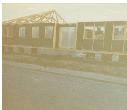
Väggar och takstol monteras
